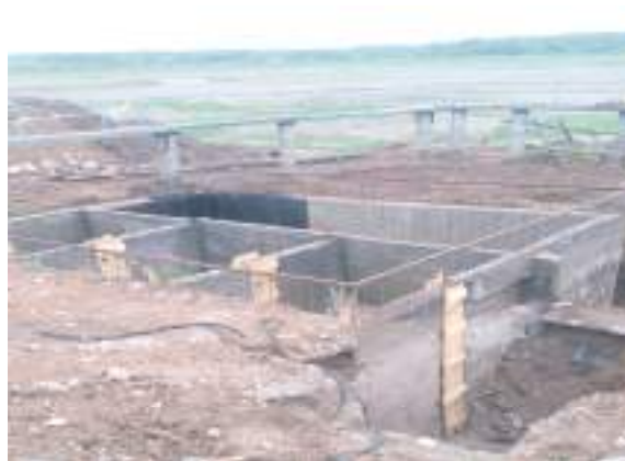
Капитальный ремонт гидроузла на р.Толмань у д.Малая Шимшурга Новоторъяльского района Республики Марий Эл
